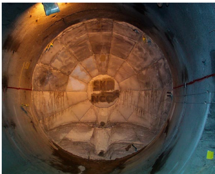
Figur 13-7. Gjuten plugg till inre sektionen i Prototypförvarstunneln vid Äspölaboratoriet.
